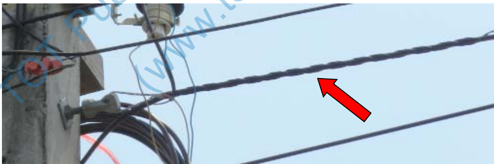
ภาพประกอบที่ 7. อุปกรณ์ Preformed Dead End for Self-Support Cable (ADSS/ARSS)
