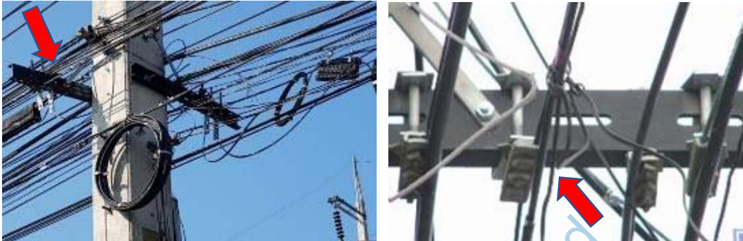
ภาพประกอบที่ 6. ตัวอย่างข่ายสายสื่อสารที่ติดตั้งบนเสาไฟฟ้าที่ตำแหน่งการติดตั้งไม่เพียงพอ
