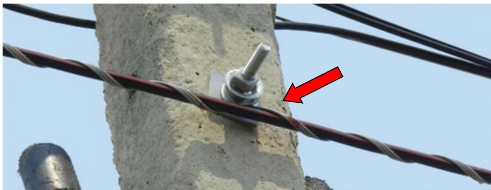
ภาพประกอบที่ 8. อุปกรณ์ Thimble Preformed Suspension for Self-Support Cable (ADSS/ARSS) (Tangent ADSS/ARSS)
