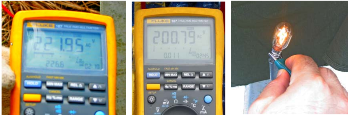
ภาพประกอบที่ 5. ความต่างศักย์ไฟฟ้าจากไฟฟ้าเหนี่ยวนำที่ปรากฏบนสายเคเบิล OFC โครงการ TNEP
