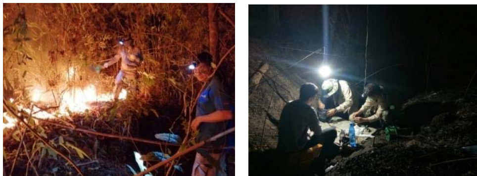
ภาพประกอบที่ 3. การซ่อมสายที่ชำรุดจากไฟไหม้สายเคเบิล OFC
