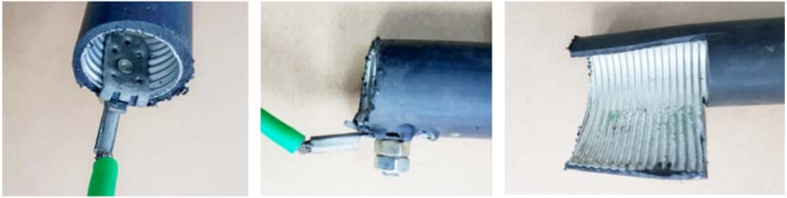
ภาพประกอบที่ 11. จุดต่อสาย Ground Wire กับ Shield ของสายเคเบิลทองแดง
