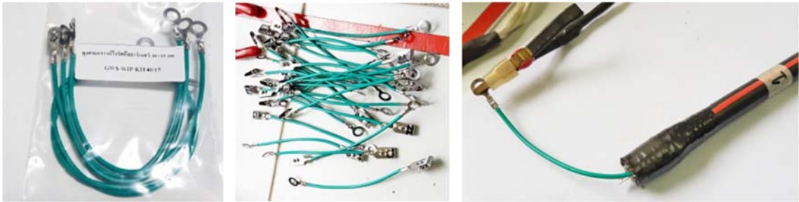
ภาพประกอบที่ 17. สาย Ground Wire ต่อกับ Corrugate Armoured Steel สาย ARSS OFC
